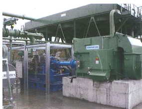
Figure 6 : Générateur (à droite) aligné avec la turbine (à gauche).
