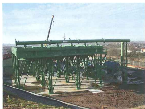
Figure 4 : Installation du système de refroidissement par air.
