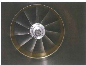
Figure 5 : Vue à l'intérieur de la turbine.
