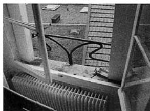
17 Détail de fenêtre .jpg
