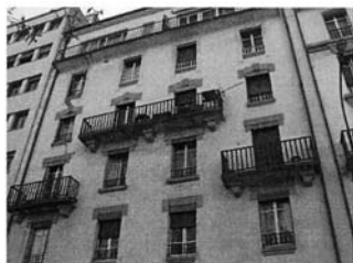
2 Détail façade rue .JPG
