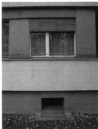
Façade sud : allèges, meneaux, fenêtre, lambrequin, fenêtre de cave
