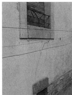
5 Soubassement côté cour.jpg
