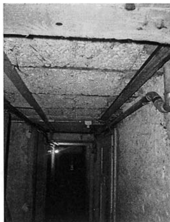
15 Plancher mixte acier-béton sur sous-sol .jpg
