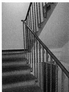
Palier du 5ème étage.JPG
