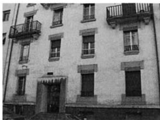
1 Détail façade rue .JPG
