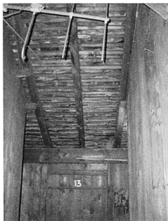
16 Couverture, ardoises sur lattage .jpg
