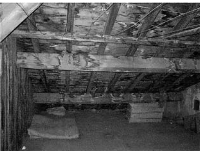
13 Toiture sur combles .jpg
