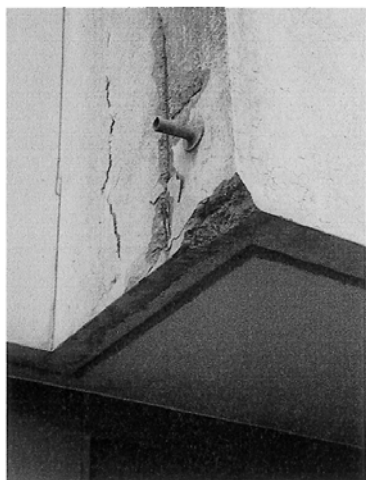
Balcon au 1 er étage, façade nord
