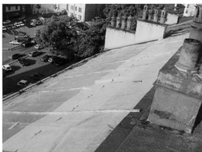
8 Réparation provisoire récente côté rue .jpg
