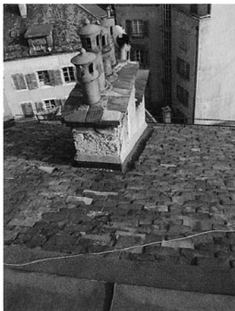
9 Couverture en ardoises côté cour .jpg
