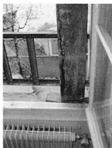
18 Etayage de fenêtre .JPG
