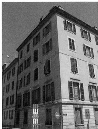
1 Angle rue Adolphe Tschumi... .jpg
