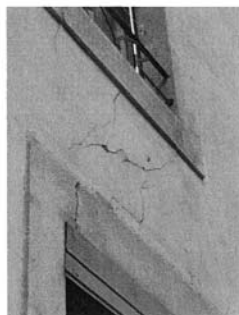
6 Détail façade sur cour.jpg
