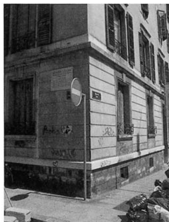
3 Eléments de façade en pierre, et en ciment .jpg
