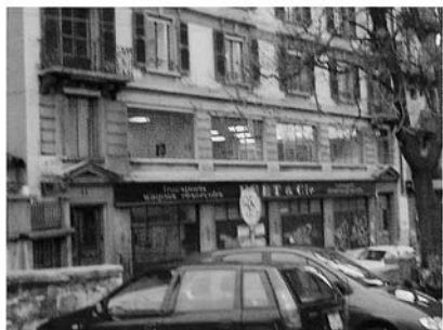
2 Façade rue, rez et entresol.jpg
