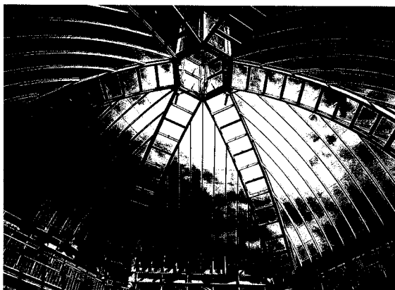
L'ossature de la coupole et du lanterneau de la serre méditerranéenne
