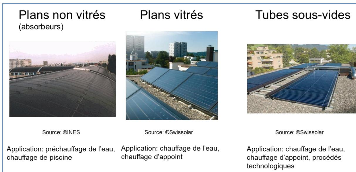
Figure 10 : technologies de capteur thermique et domaines d'application
