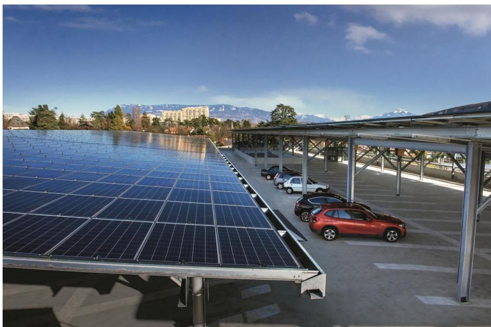
Figure 3 : exemple de carport solaire à Sous-Moulin (crédit photo : SIG)
