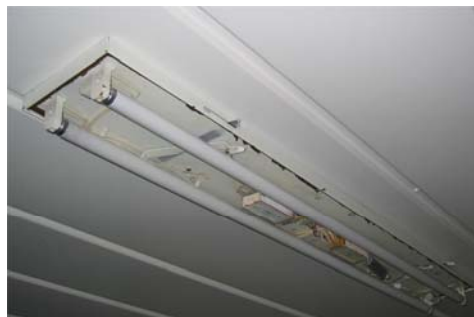
Figure 2 : Luminaire sans le cache
