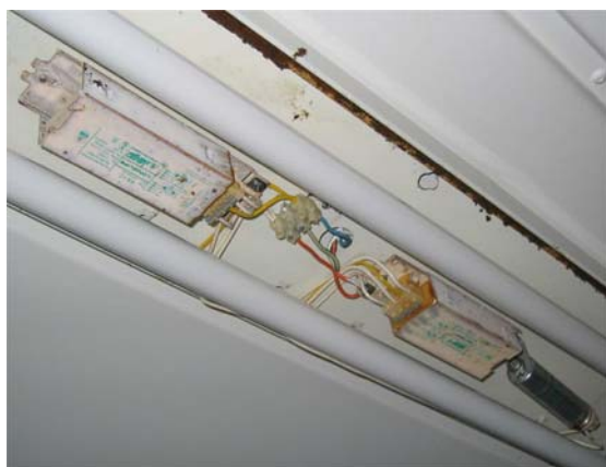
Figure 3 : système électronique - condensateur sur la droite
